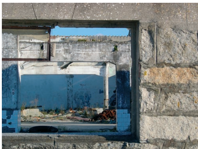
A antiga nave de Conservas Yago na actualidade. Foto: Lino Prieto
